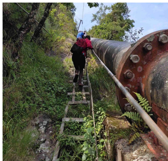
Potrubiie na pohon turbíny na výrobu elektriny. Nandi hills
